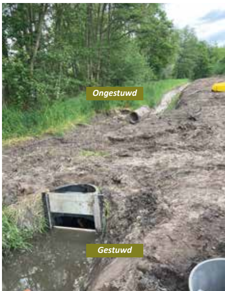
Regelbare stuw op een perceelsgracht. Stroomopwaarts van de stuw is de waterstand in de gracht hoger dan stroomafwaarts, het overtollige water stroomt nog steeds weg.
