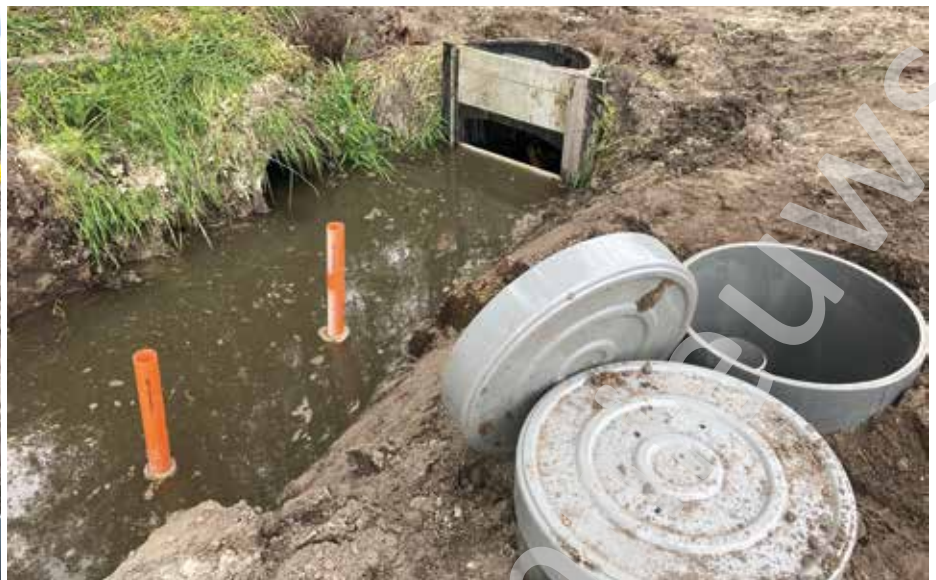
Regelbare stuw op een perceelsgracht. Stroomopwaarts van de stuw is de waterstand in de gracht hoger dan stroomafwaarts, het overtollige water stroomt nog steeds weg.
