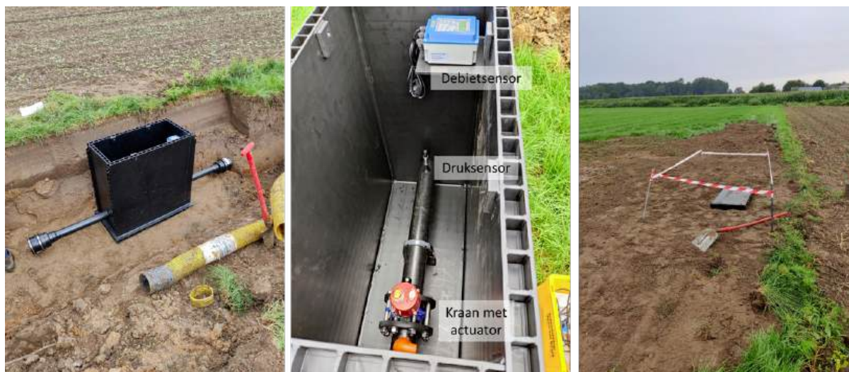
Figuur 38: Illustratie van het plaatsen en de afwerking van het uitstroompunt van blokken A en B
