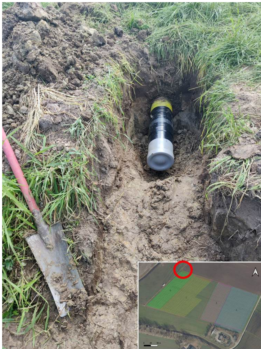
Figuur 36: Originele afsluiting van de uitlaat van blokken A en B
