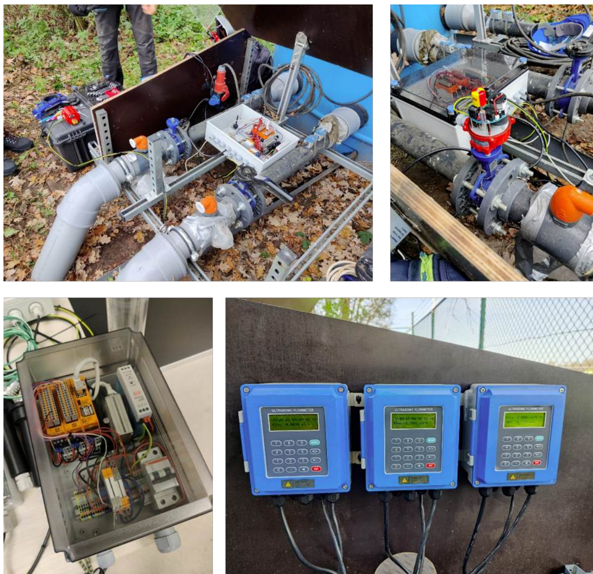
Figuur 39: Installatie van de telemetrie aan het instroompunt
