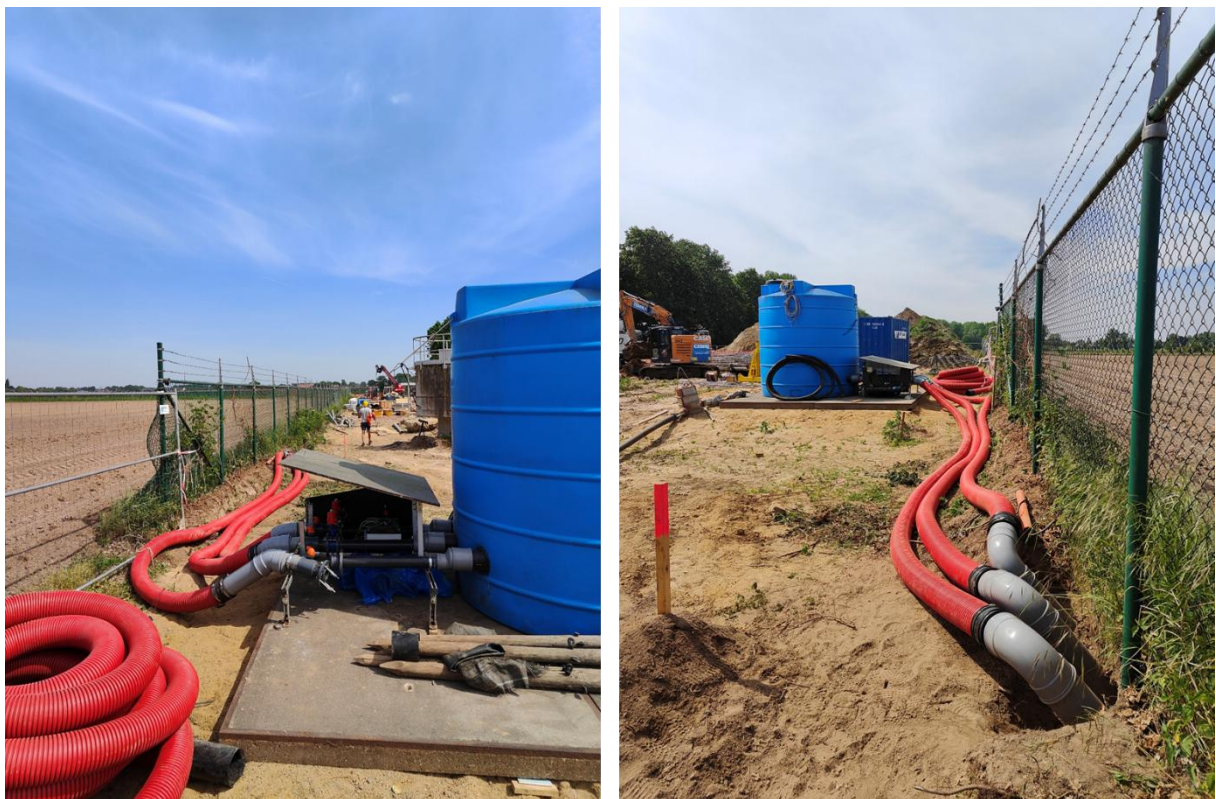
Figuur 19: Situatie na aankoppeling met flexibele buis
