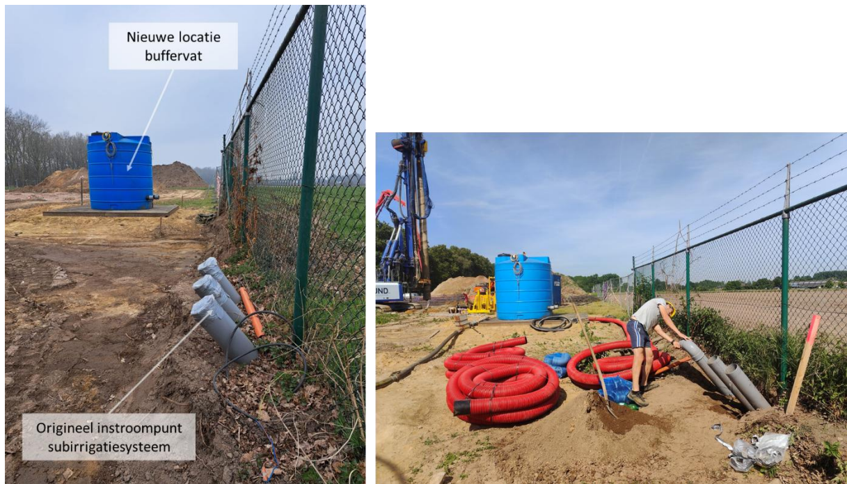
Figuur 18: Situatie na verplaatsing buffervat en aankoppeling met flexibele buis 110 mm
