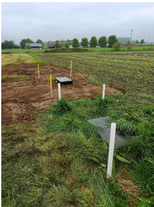
Figuur 10: Situatie na plaatsing nieuwe monitoringsput
